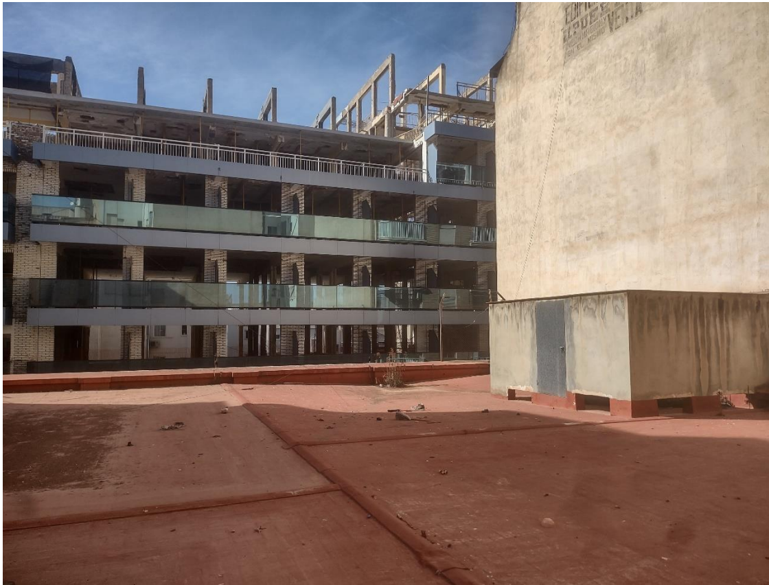
Vista desde la azotea del edificio existente.
