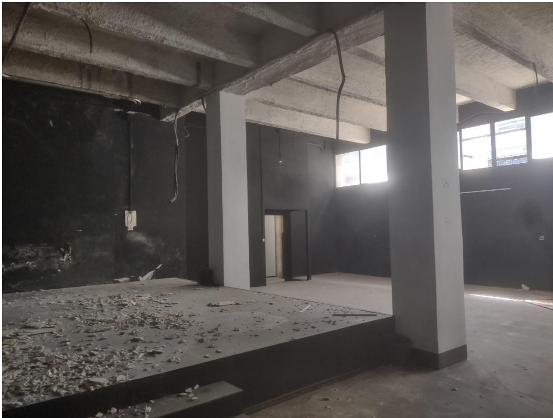
Vista del interior del edificio existente.
