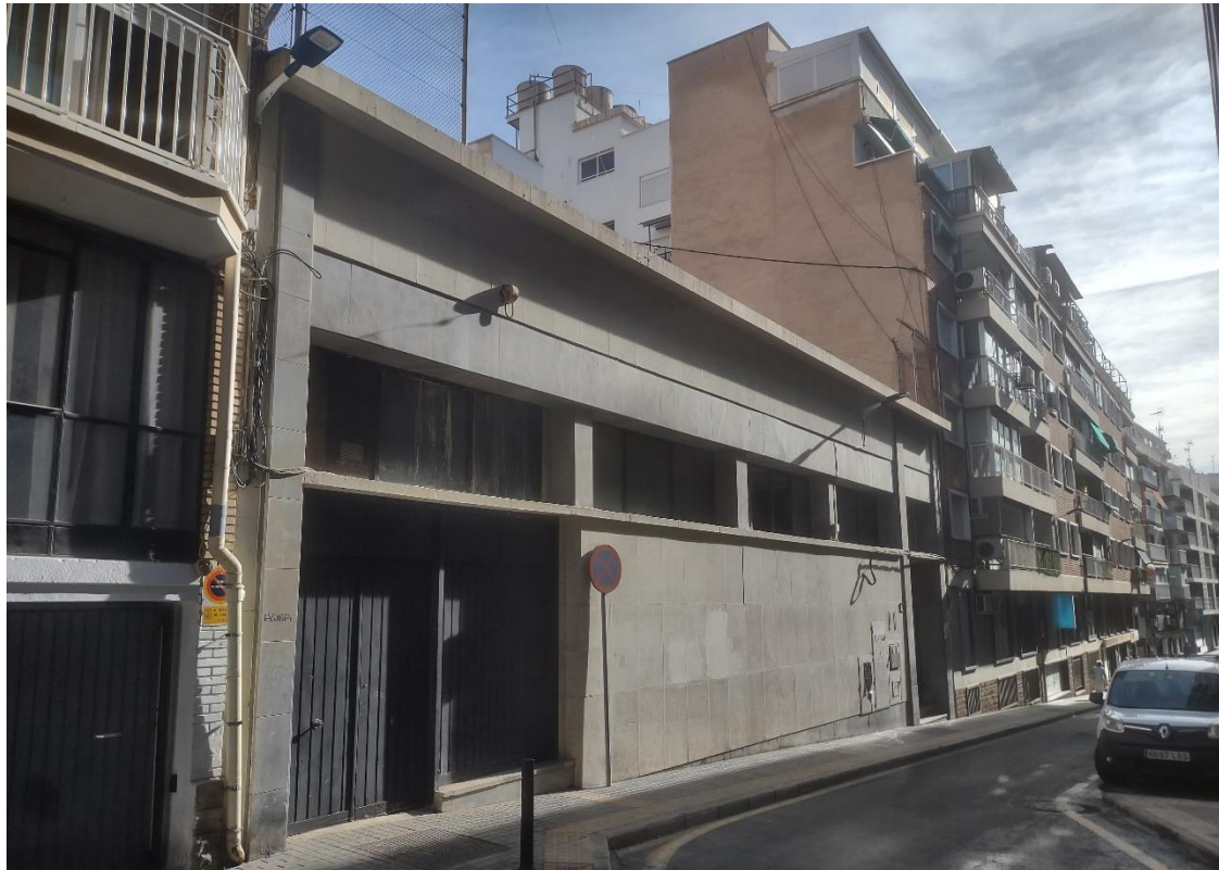
Imagen de la fachada del edificio existente y medianera del edificio colindante, avenida de los Almendros nº5.
